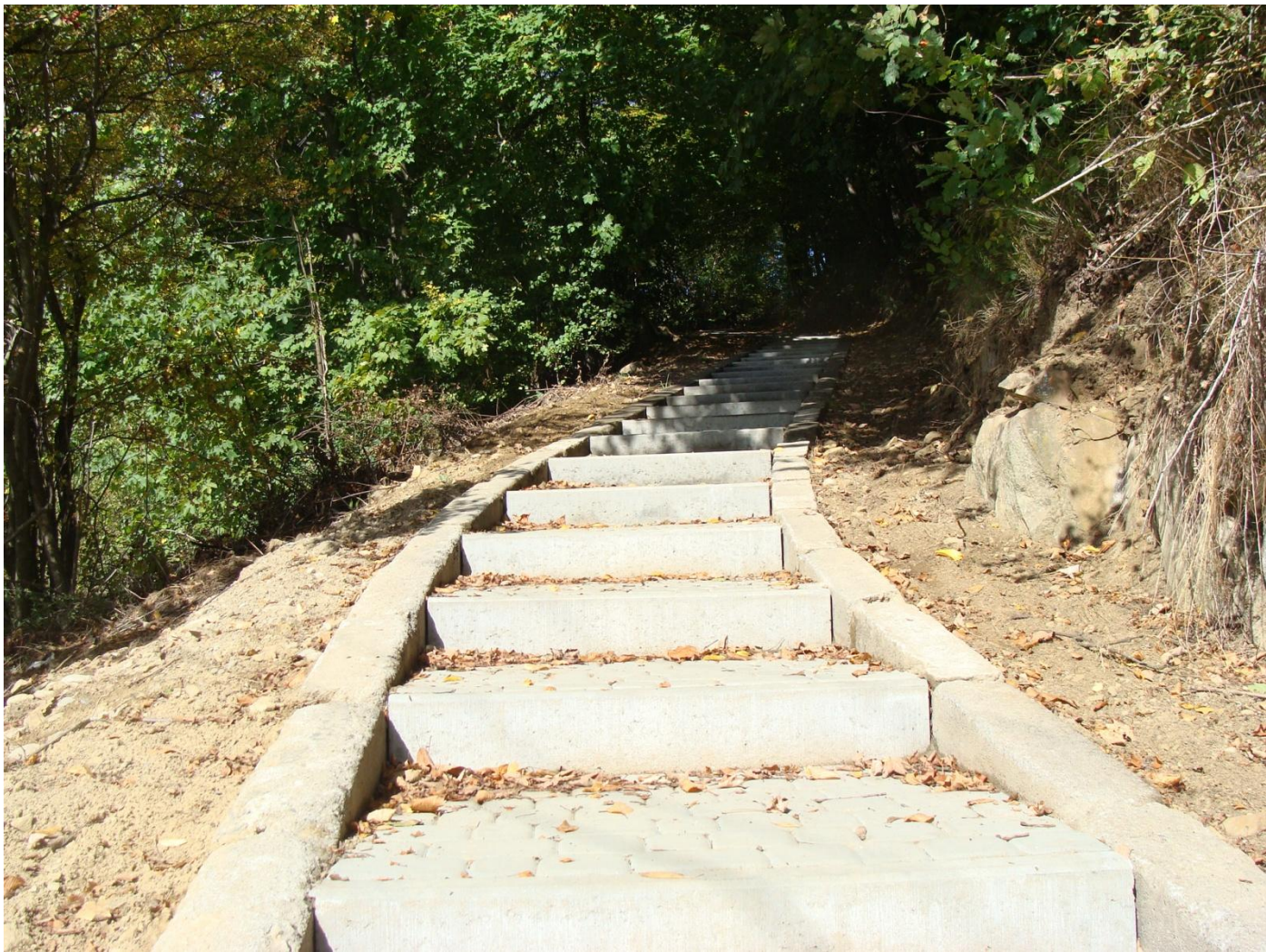
Stan po zakończeniu realizacji operacji
